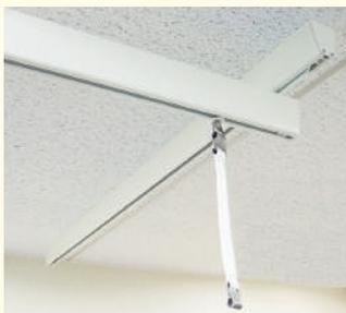
新築や改築の際にレールを設置します。天井裏の補強材からレールを取り付けるので部屋の内観もスッキリとしたまま設置が可能です。
